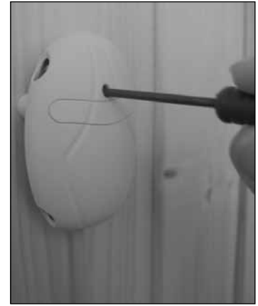
Kuva 11. Ylikuumenemissuojan palautuspainike Bild 11. Överhettningsskyddets återställningsknapp
